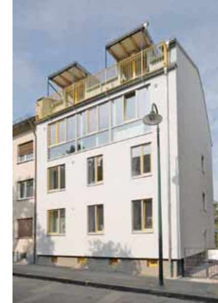
Die extravaganten Gauben verleihen dem gesamten Gebäude ein modernes Gesicht.
